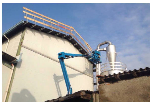
6. Montaggio parapetti con PLE
