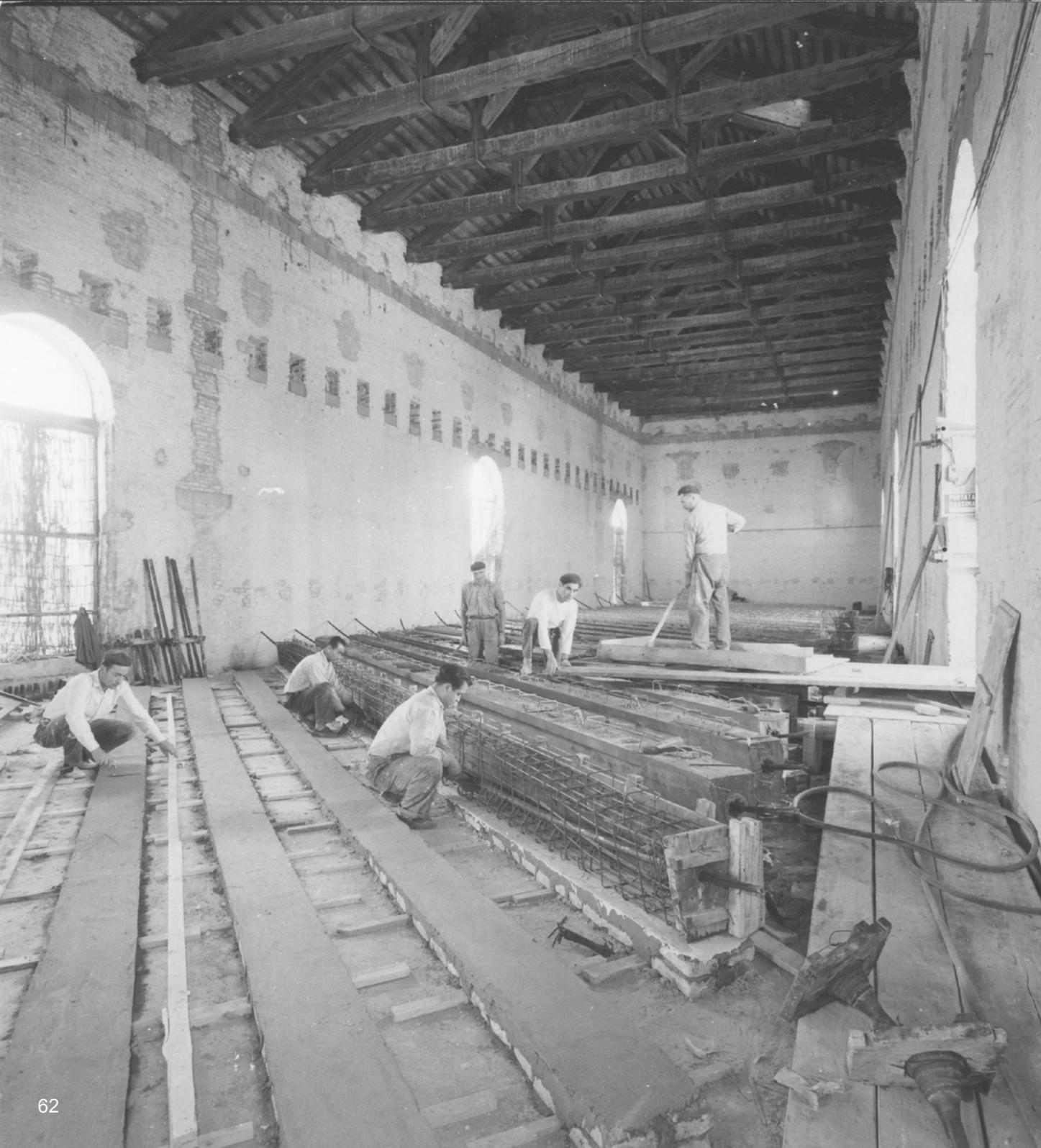
Costruzione a piè d'opera delle travi in calcestruzzo armato precompresso per formare il nuovo solaio intermedio nella sala capitolare
